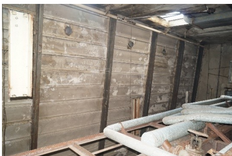
zdj. 11 Płyty dachowe oraz konstrukcja dachu 02
