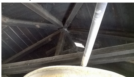
zdj. 14 Konstrukcja dachu 04
