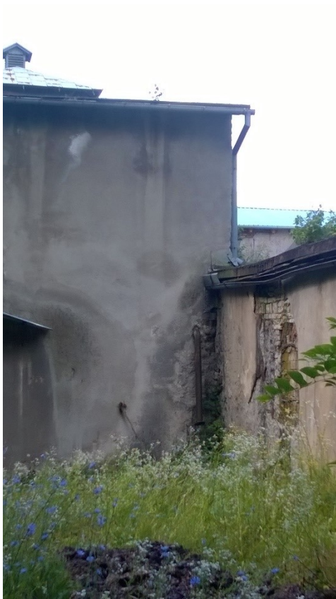
zdj. 15 Elewacja północna
