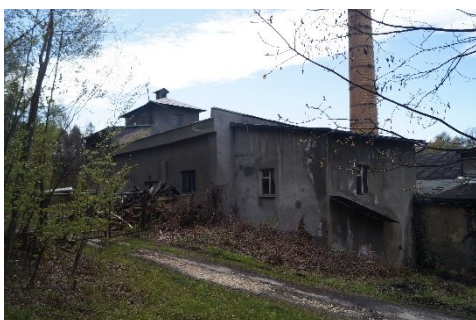
zdj. 8 Elewacja północno-wschodnia
