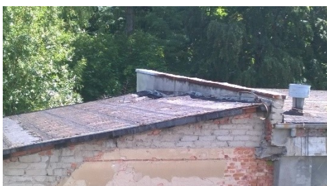
zdj. 10 Dach budynku 01 na rys.
