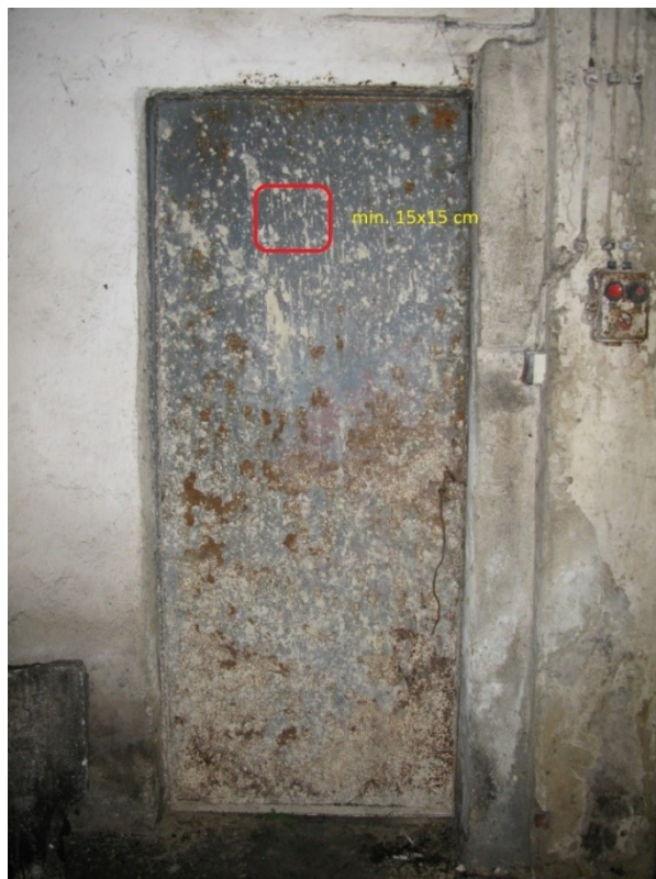
Zdj. 7: Miejsce wykonania wlotu.
