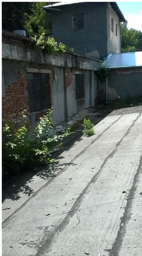
zdj. 16 Elewacja zachodnia
