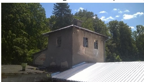
zdj. 13 Widok na wieżę ciśnień (dach 04)
