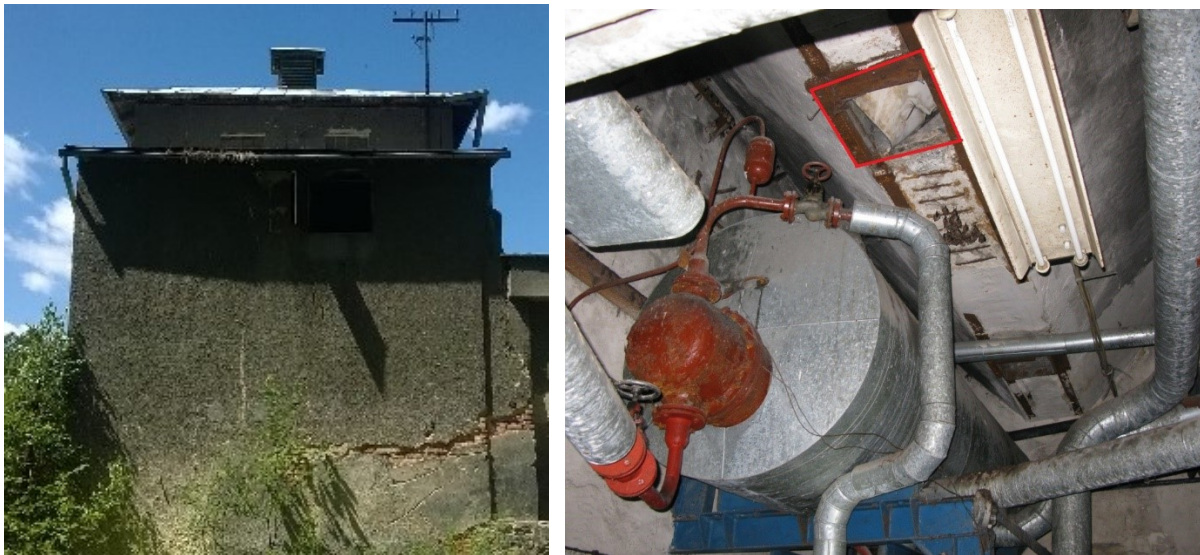
Zdj. 3 i 4: Widok na okienko wlotu dla nietoperzy w miejscu wsypywania opału stałego oraz miejsce przelotu od wewnątrz budynku (na czerwono).
