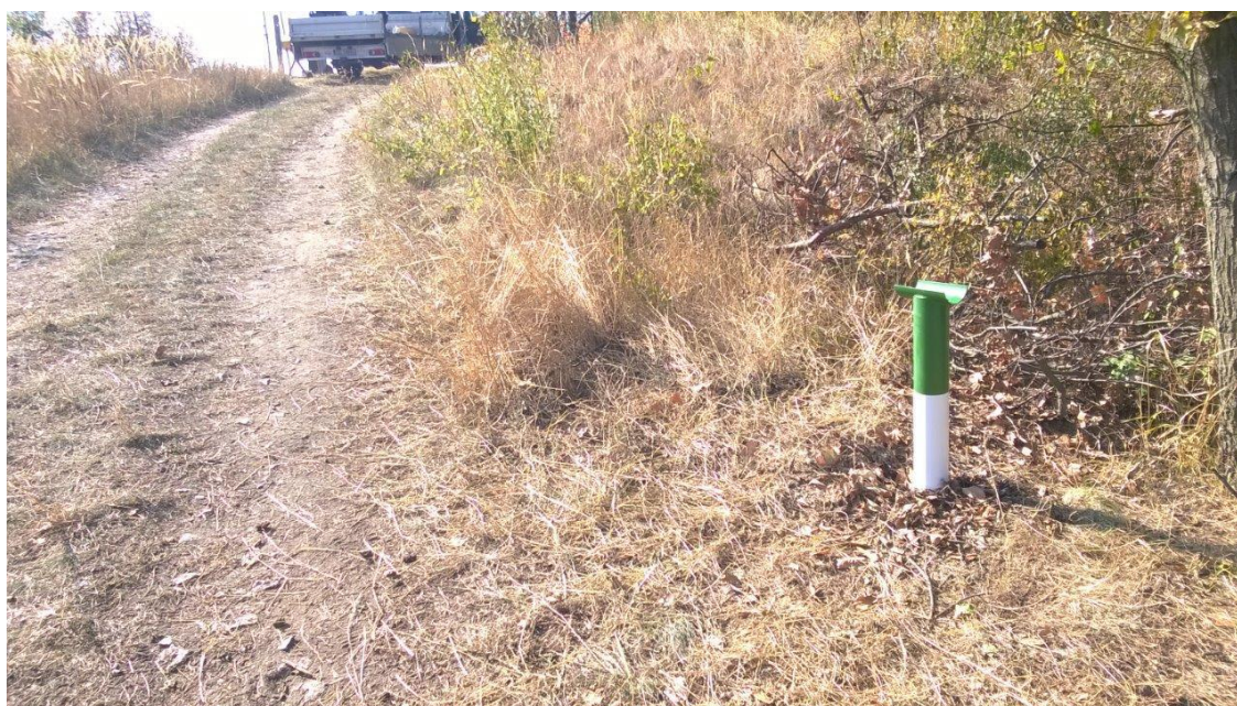
Ryc.4 Podpora wykorzystywana na czas otwarcia szlabanu
