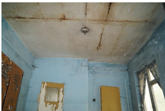
fot. 5. Widoczne zacieki w pomieszczeniach budynku
