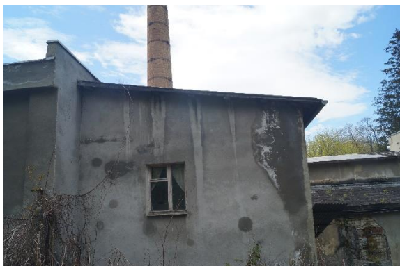
fot. 3. Elewacja wschodnia, widoczne zacieki
